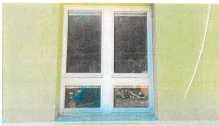
Fotografia č. 6 – Pohľad na zostavu dvoch drevených okien zo strany exteriéru na 1.NP v hornej časti otváravosklpné a v dolnej časti sklpné.
