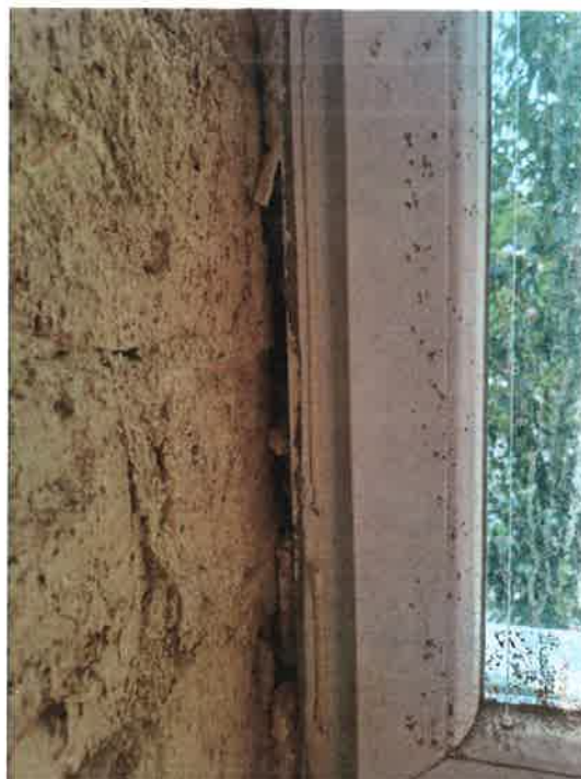
Obrázok 2 - Prípojná špára v rozpore s STN
