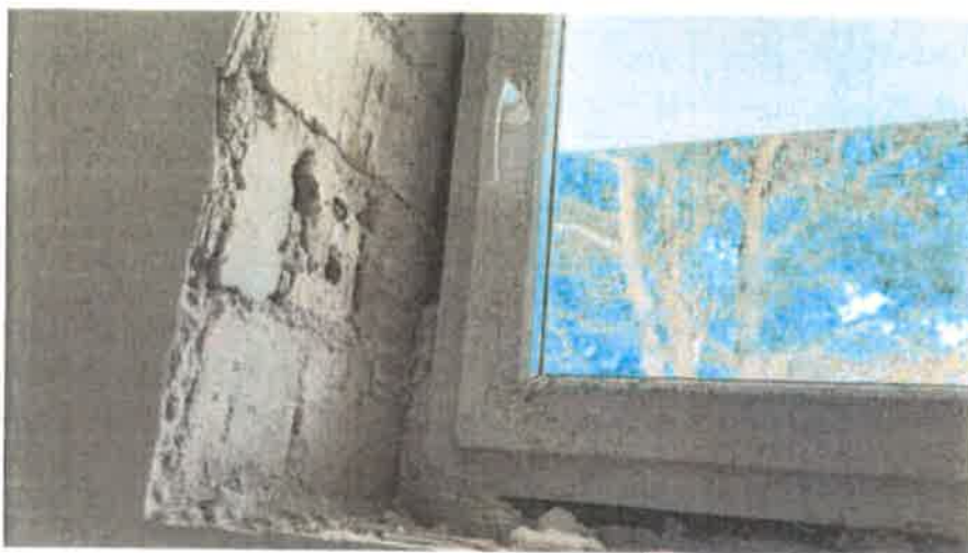
Fotografia č. 22 – Pôvodné okná sú s nesprávnou pripojovacou škárrou.
