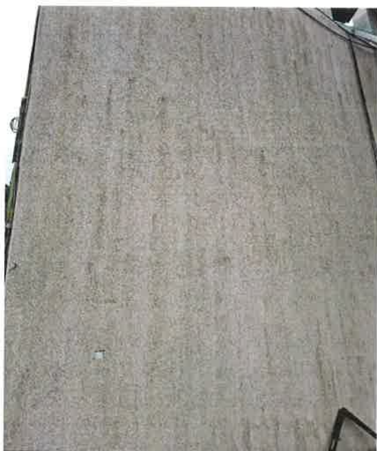
Obrázok 10 jestvujúca fasáda objektu
