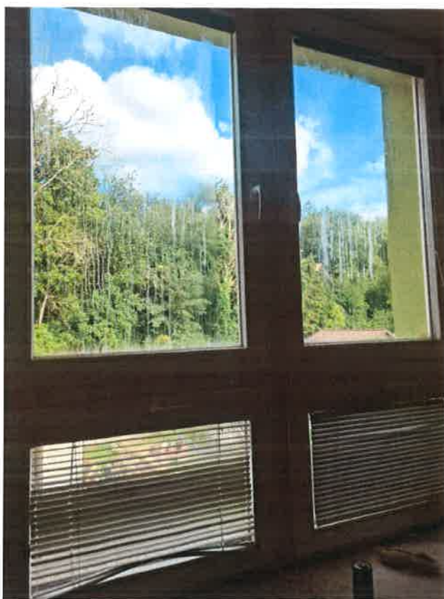
Obrázok 1 - zatečenie v medzisklenom priestore
