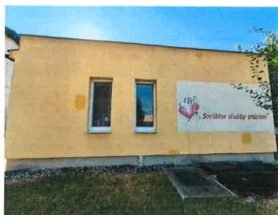
Obrázok 3 jestvujúca fasáda objektu
