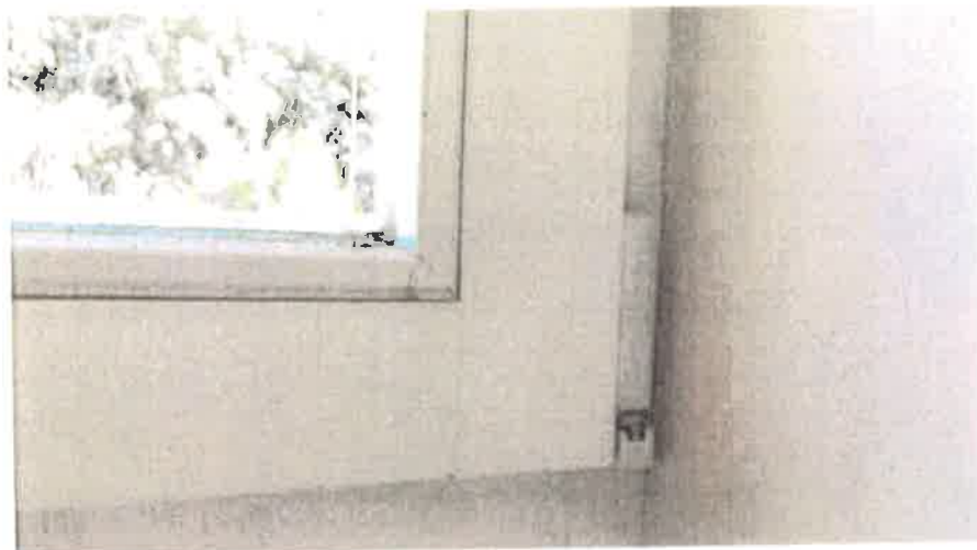
Fotografia č. 13 – Pohľad na roh dreveného okna zo strany interiéru.
