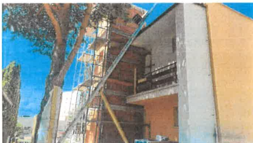
Fotografia č. 2 - Pohľad juhozápadný na rozostavanú budovu Centra sociálnych služieb v Kežmarku.
