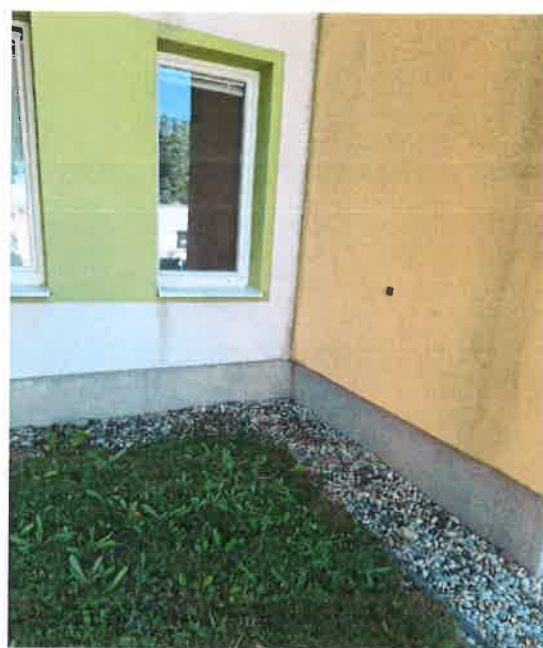
Obrázok 11 jestvujúca fasáda objektu
