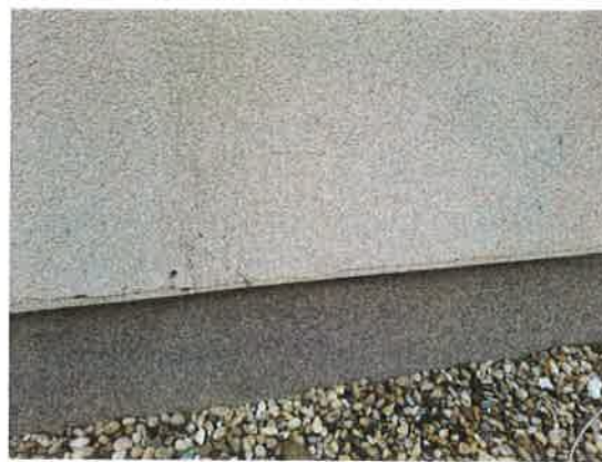
Obrázok 9 jestvujúca fasáda objektu
