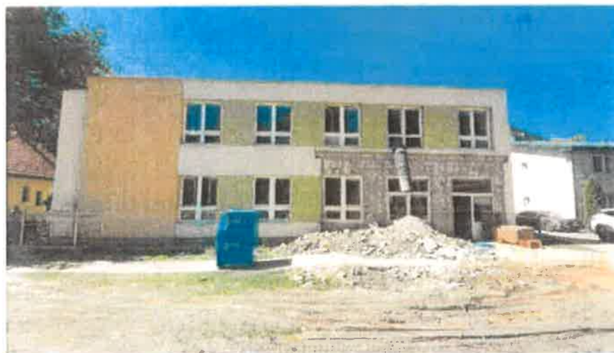
Fotografia č. 3 - Pohľad juhovýchodný na rozostavanú budovu Centra sociálnych služieb v Kežmarku.
