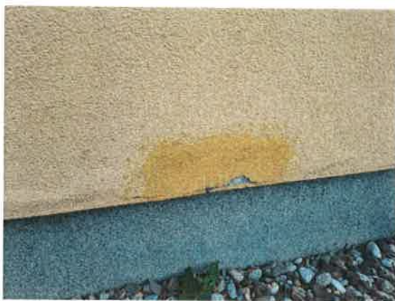
Obrázok 8 jestvujúca fasáda objektu
