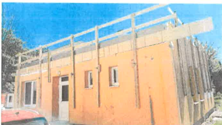
Fotografia č. 4 - Pohľad severovýchodný na rozostavanú budovu Centra sociálnych služieb v Kežmarku.
