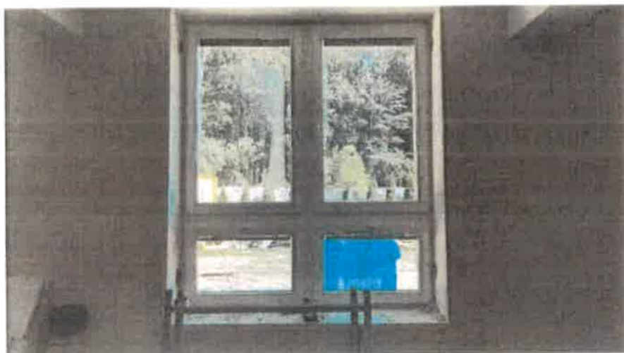
Fotografia č. 11 - Pohľad na zostavu dvoch drevených okien zo strany interiéru na 1.NP v hornej časti otváravosklopné a v dolnej časti sklopné.
