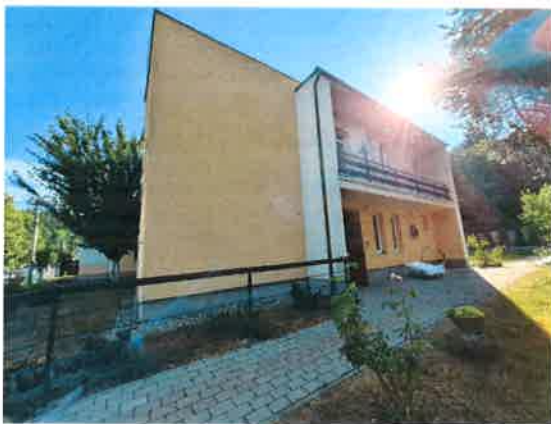
Obrázok 4 jestvujúca fasáda objektu
