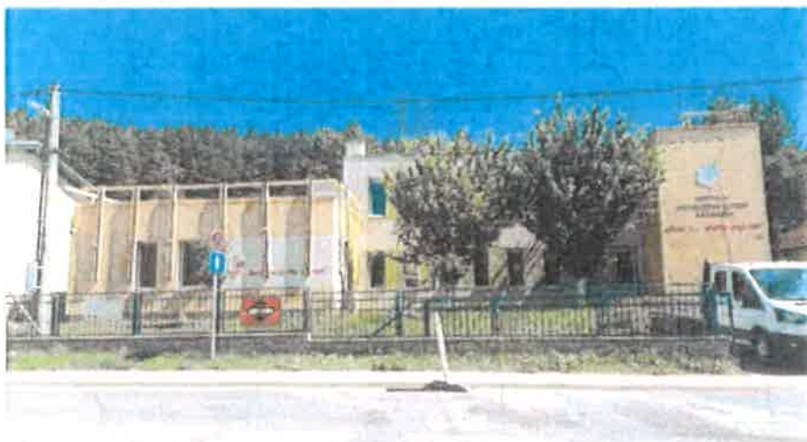
Fotografia č. 1 – Pohľad severozápadný na rozostavanú budovu Centra sociálnych služieb v Kežmarku.
