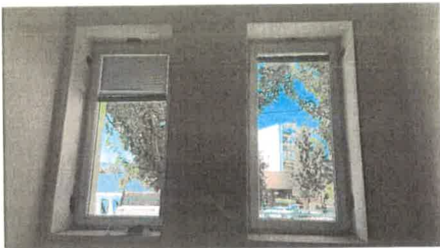
Fotografia č. 16 – Pohľad na samostatné plastové otváravosklopné okná zo strany interiéru na I.NP.
