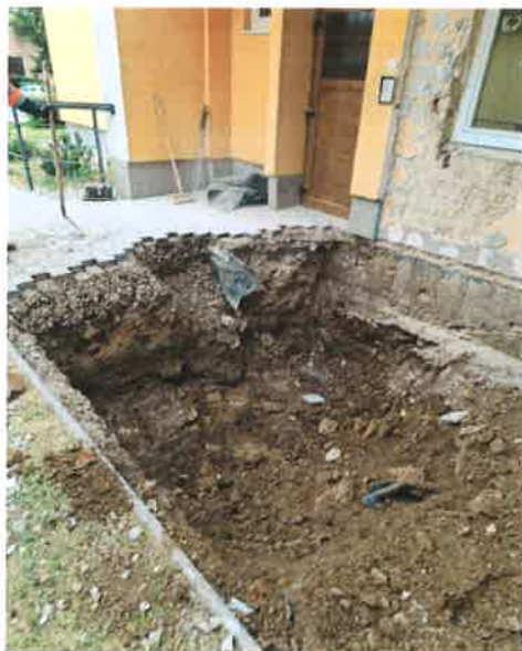
Obrázok 2 - výkop pre ZŠ výťahovej šachty
