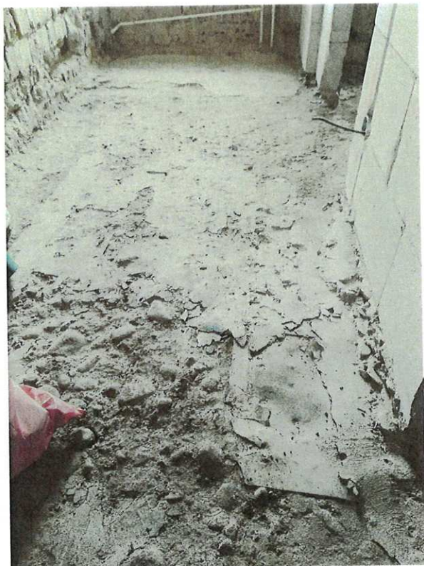
Obrázok 7 – Degradácia čiastočnej hydroizolácie vnút. muríva
