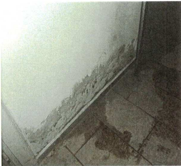
Obrázok 1 - Zavlhnutie muriva pri podlahe
