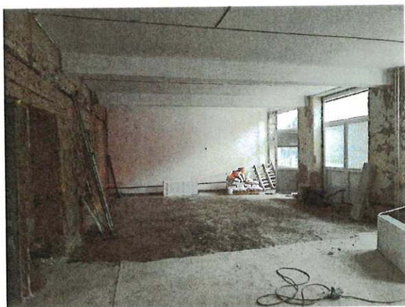
Obrázok 8 , 9 – Chýbajúca hydroizolácia, tepelná izolácia a podkladný betón po odstránení vrchnej betónovej mazaniny exist. podlahy
