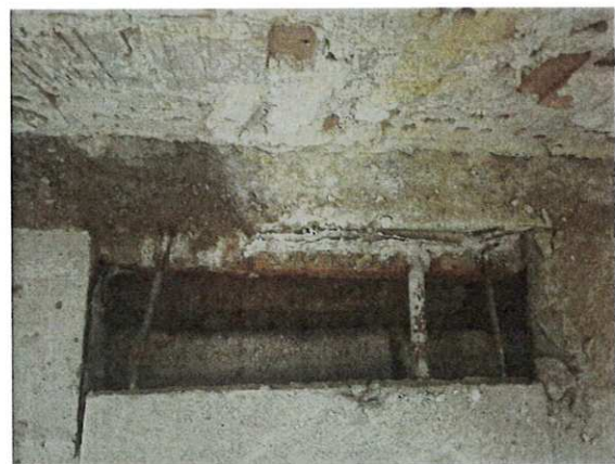
Obrázok 4 – Sonda – teplovodný kanál
