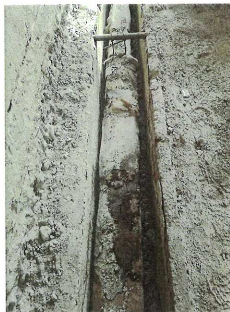
Obrázok 11 – Jestvujúci teplovodný kanál
