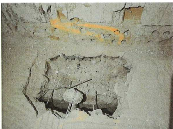
Obrázok 5 – Sonda pri obvodovom murive
