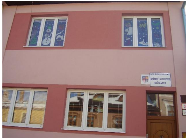
Budova úseku ekonomiky a vnútornej prevádzky a kancelárie riaditeľky CSS Kežmarok
